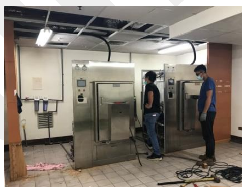
廠商與本院工務協調管路拆卸
