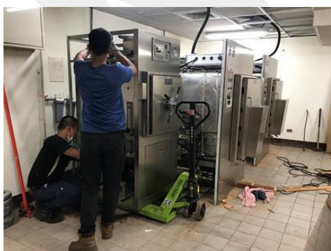
EO 消毒鍋從隔間拆卸及移出後
